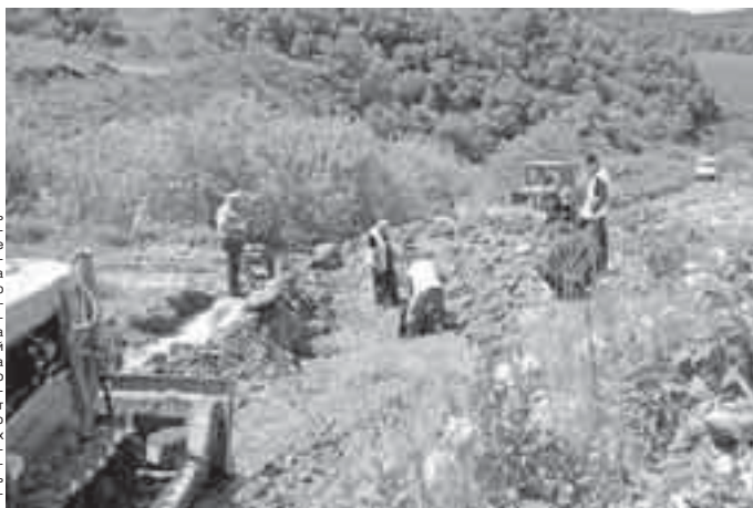
Восстановительные работы на автодороге Былым – Актюпарк
