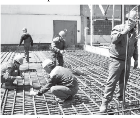
Монтажные работы идут полным ходом.
