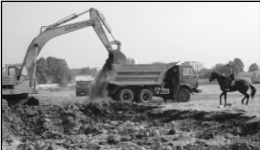
Земляные работы на месте будущей подземной конюшни.
